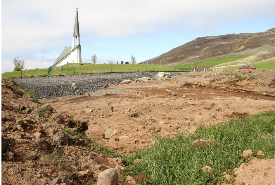
Mynd 11. Horft yfir framkvæmdasvæðið við Mosfellskirkju. Ljósmynd: Ragnheiður Traustadóttir.
